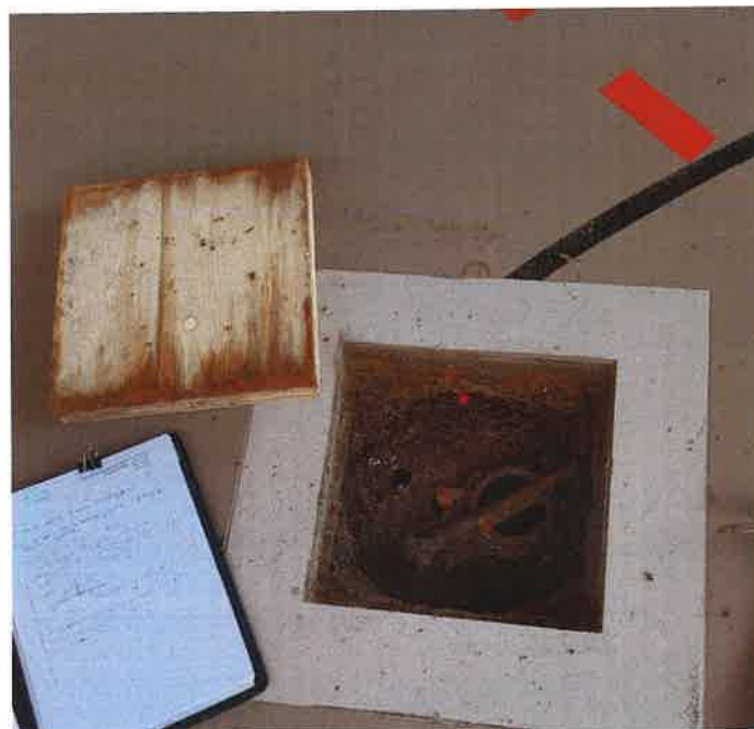
Abbildung 19: Stark korrodiertes Einbauteil der Bodenhülse, Dreichschichtplatte der Abdeckung nass.
