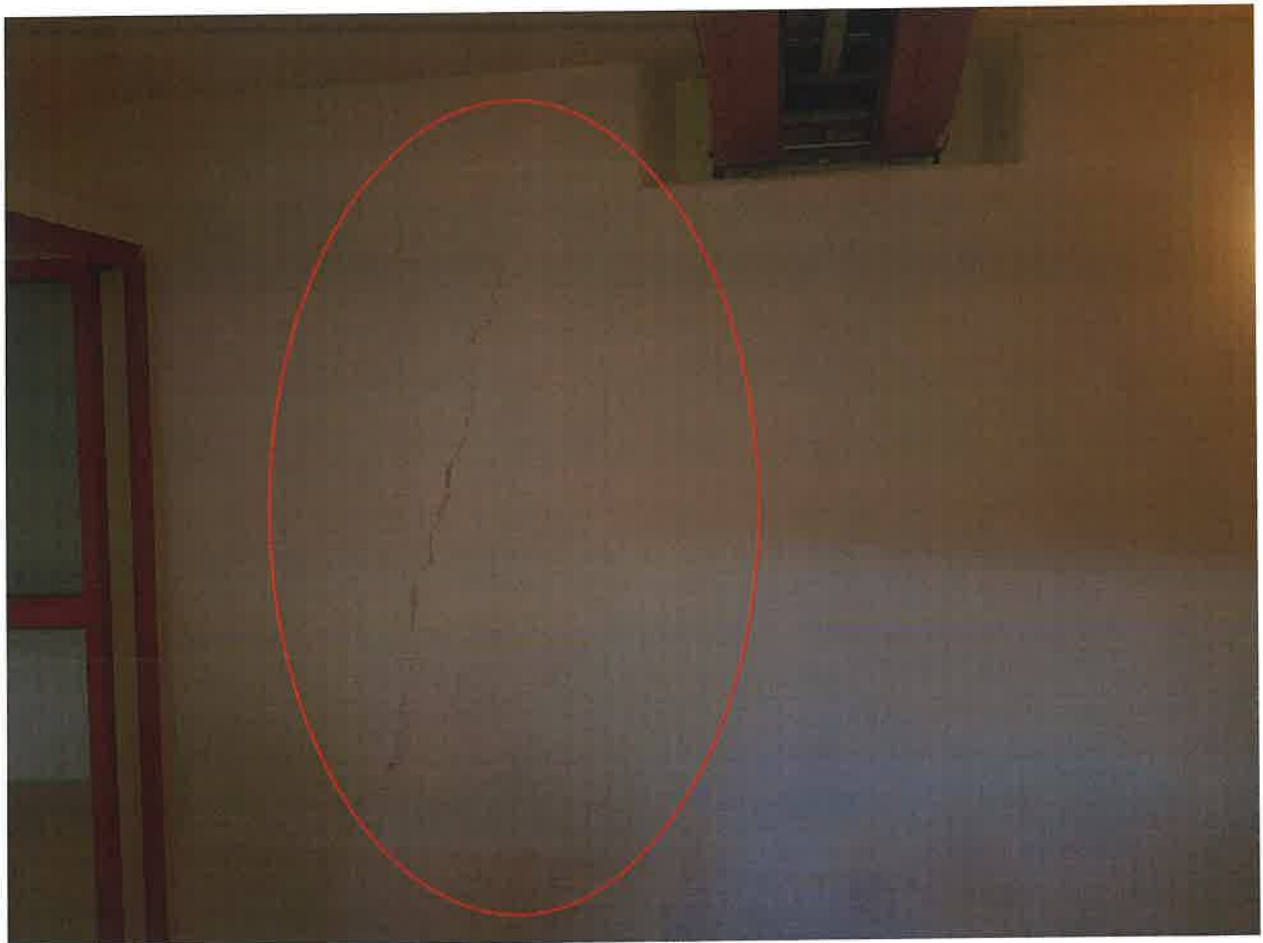
Abbildung 23: Rissbildung in der Außenwand, Bereich Achse N / 9
