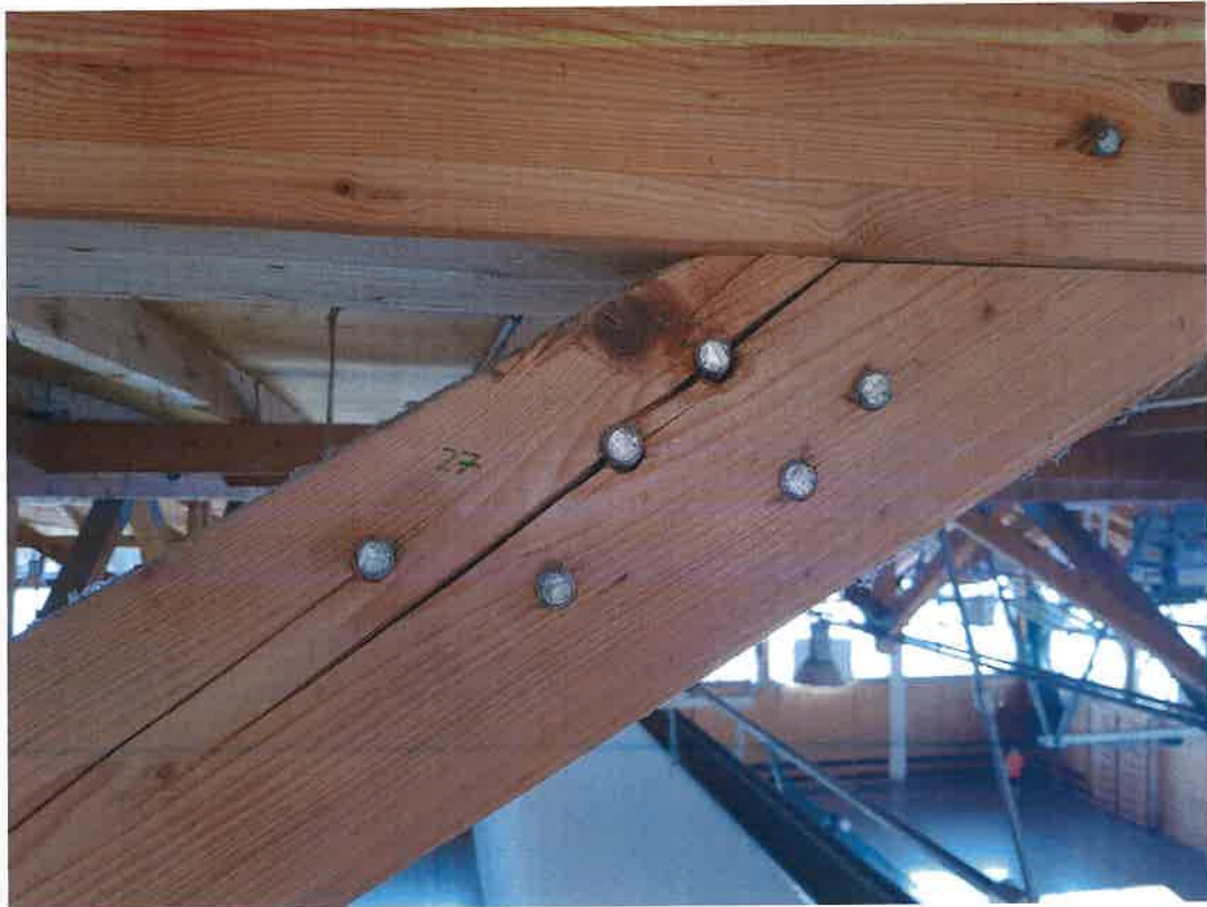
Abbildung 12: Rissbildung im Anschlussbereich der Stabdübel bei Prüfstelle Nr.27. Holzquerschnitt ist bis zum Schlitzblech durchgerissen.
