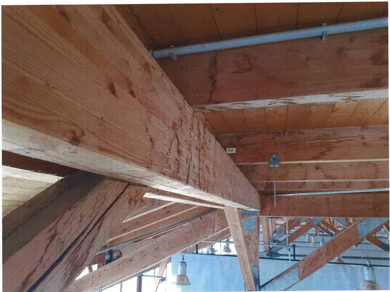
Abbildung 4: Ablaufspuren des vergangen Wassereintrags an den Bauteilen der Dachkonstruktion.
