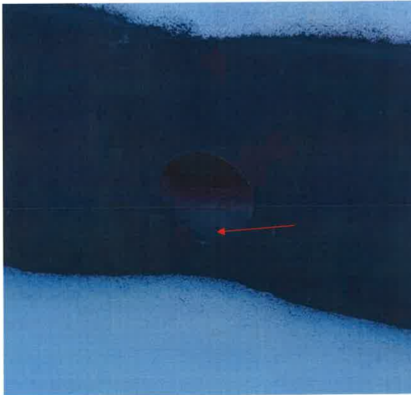
Abbildung 22: In den Notüberläufen ist augenscheinlich eine Art Bauschaum erkennbar.
