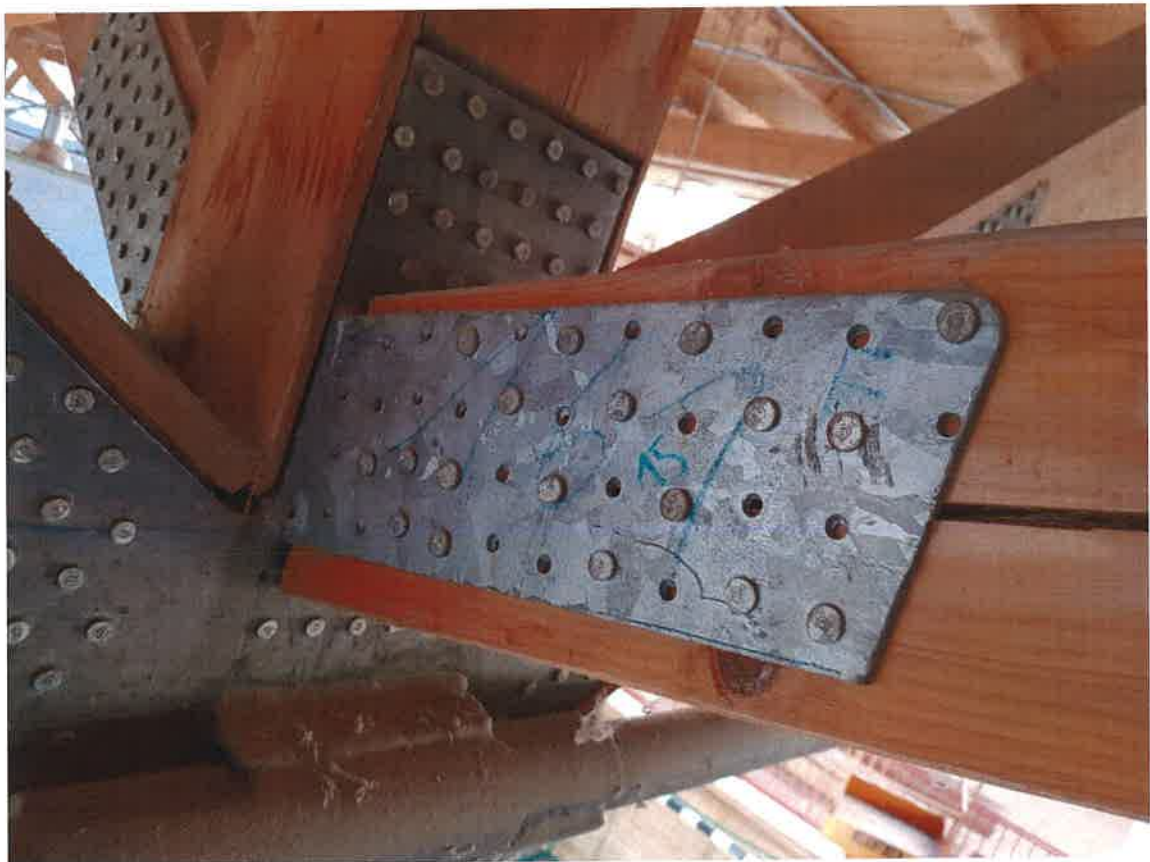
Abbildung 11: Prüfstelle Nr.15; Rissverlauf bis in den Lochblechanschluss. Augenscheinlich liegt die zweit-unterste Nagelreihe im Rissverlauf.
