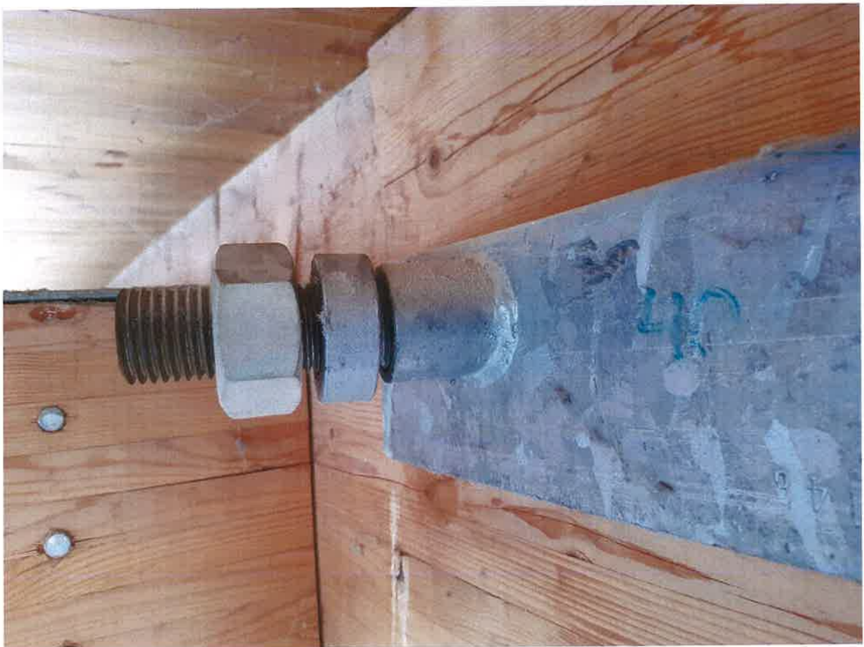
Abbildung 16: Spannmutter der Windverbände. Prüfstelle Nr.40
