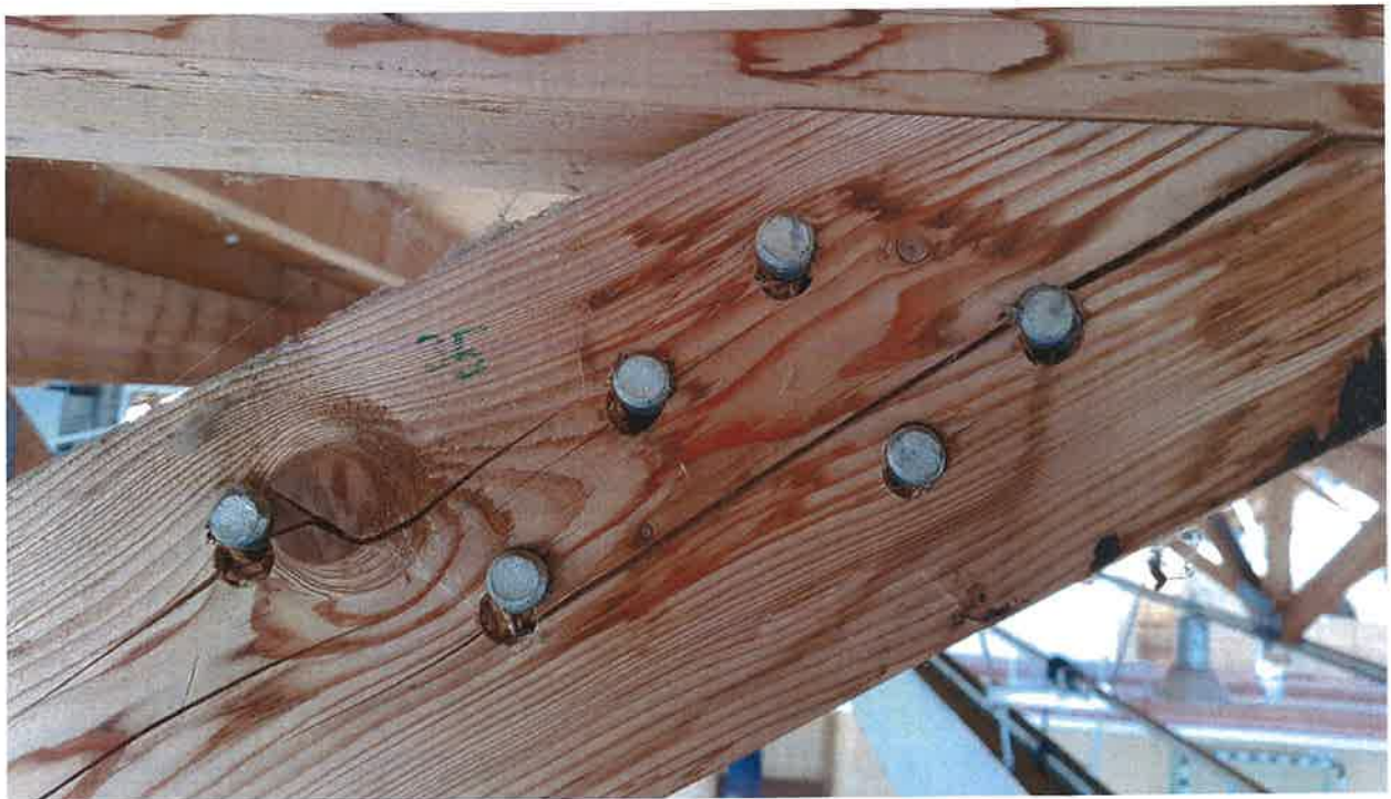
Abbildung 13: Rissbildung und Fehlbohrungen im Anschlussbereich der Stabdübel bei Prüfstelle Nr.35. Stabdübel konnten per hand rausgedrückt werden.
